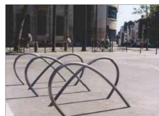
Estrutura em tubo curvado em aço galvanizado
